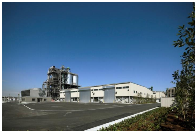
川崎バイオマス発電施設
